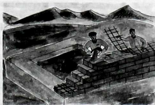
94-сүрөт. Горизонталдык торчолорду таштоо
