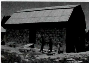
16-сүрөт. Темир-бетон өзөктүү жана өзөктүн аралыгы чийки төө-кыштан жасалган материалдардан тургузулган үйлөр
