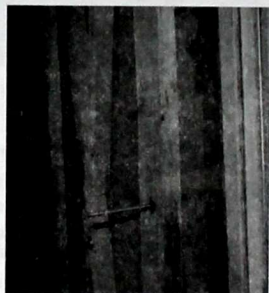
111-сүрөт. Үйдүн дубалын бекемдөөдөгү ташталмаларды, түркүктөрдү жана жантык тирөөчтөрдү өз-ара бекитүү
