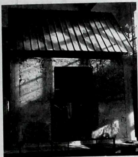
14-сүрөт. Темир-бетон өзөктүү жана өзөктүн аралыгы саман аралашкан ылай менен толтурулган үйдүн жалпы көрүнүшү
