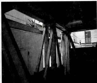
10-сүрөт. «Сынч» түрүндөгү үйдүн моделинин өзөктөрүнүн ичин толтуруу
