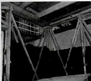
10-сүрөт. «Сынч» түрүндөгү үйдүн моделинин өзөктөрүнүн ичин толтуруу
