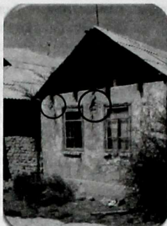
89-сүрөт. Ылай-топурактан тургузулган үйлөрдүн жер титирөөнүн натыйжасында жүк көтөрүүчү дубалдардын мүнөздүү бузулуулары
