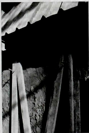
112-сүрөт. Түркүктөрдүн, жанык тирөөчтөрдүн жана ташталмалардын кошулган түйүндөрү жана аларды бириктирүүчү тактайларга бекитүүнүн көрүнүштөрү
