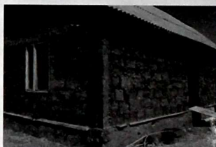
16-сүрөт. Темир-бетон өзөктүү жана өзөктүн аралыгы чийки төө-кыштан жасалган материалдардан тургузулган үйлөр
