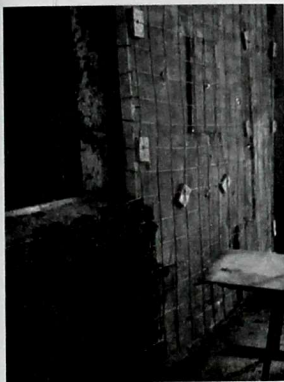
114-сүрөт. Вертикалдык темир торчолорду шыбактын сыртынан аларга 15–20 мм тийгизбей, үстүнөн кум-цемент аралашмасы менен шыбайт.
