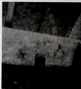
111-сүрөт. Үйдүн дубалын бекемдөөдөгү ташталмаларды, түркүктөрдү жана жантык тирөөчтөрдү өз-ара бекитүү
