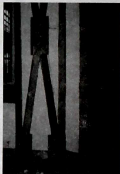
113-сүрөт. Түркүктөр менен жантак тирөөчтөрдүн араларына жылуулочу пенопласты толтуруунун жалпы көрүнүштөрү
