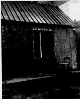
114-сүрөт. Вертикалдык темир торчолорду шыбактын сыртынан аларга 15–20 мм тийгизбей, үстүнөн кум-цемент аралашмасы менен шыбайт.
